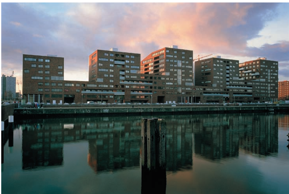
■ De Architekten Cie, De Landtong, Rotterdam, 1998 Vista verso nord ovest.
